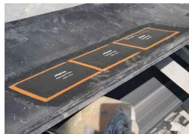
アースコンベヤパッチL2 3枚重ね貼り修理
